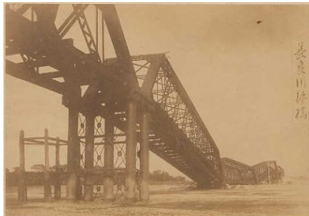
くずれた長良川鉄橋
